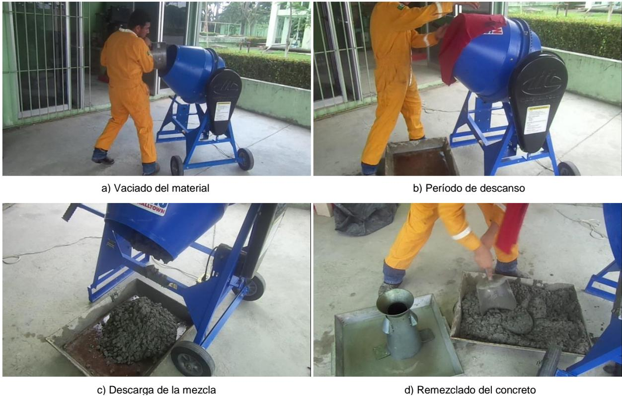
**Figura 22. Elaboración de la mezcla de concreto.**
